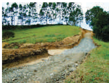
Vía en Construcción por Predio El Descanso
